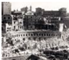
Demolizioni anni '30 Roma
