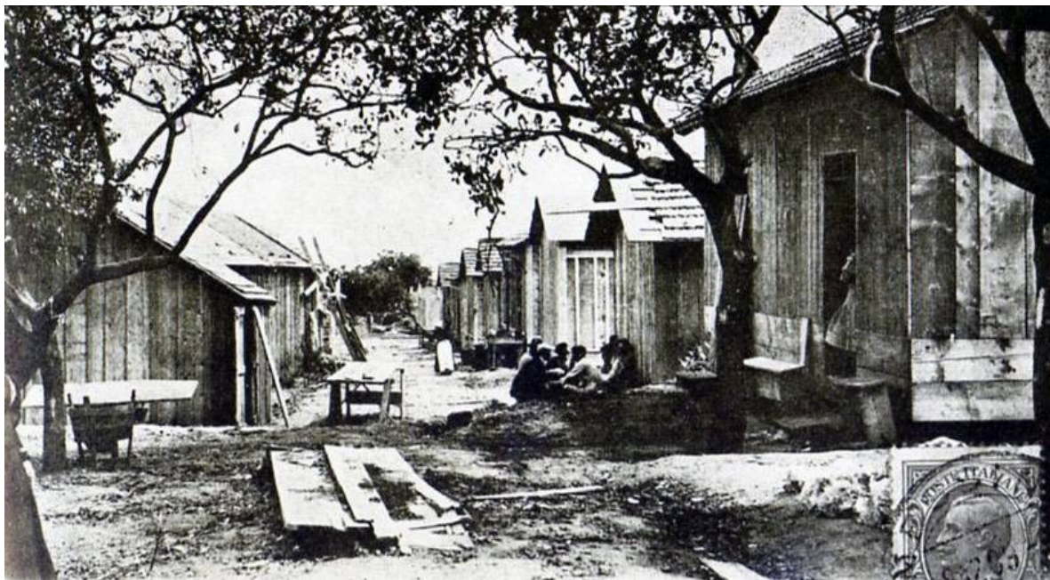
La costruzione di baracche sul piano della Mosella Fonte: www.grifasi-sicilia.com
