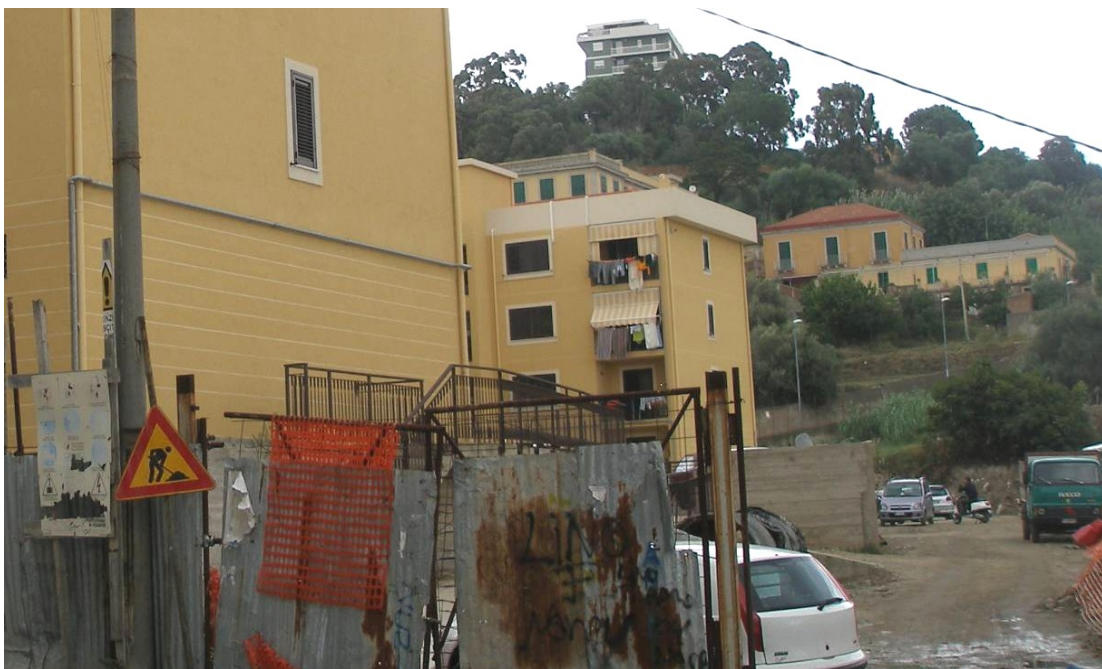
Cantiere aperto e abitato a Fondo De Pasquale foto Cristian Dalmasso
