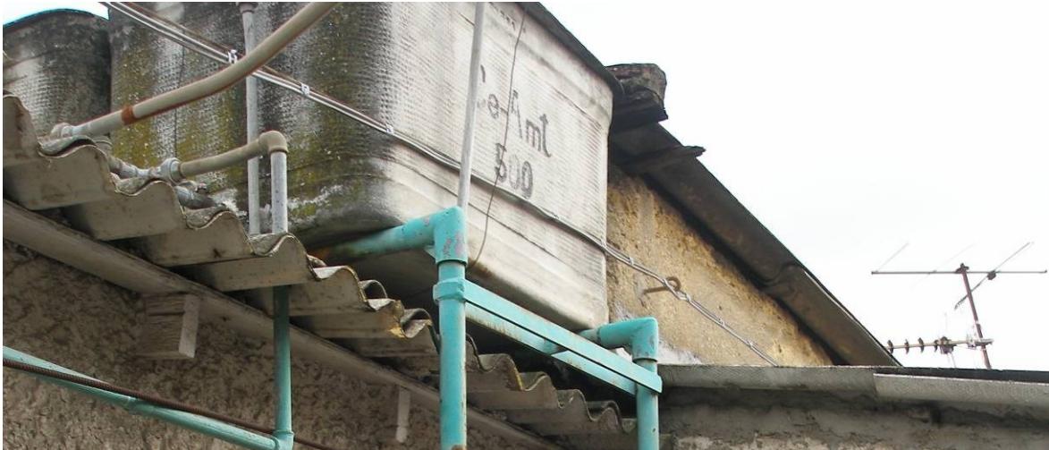
Tetti e cisterne in Eternit ad Annunziata e in Via Taormina foto Cristian Dalmasso
