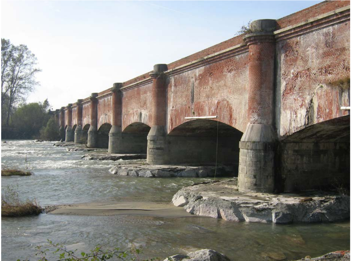
Figura 2. Il ponte-canale presso il fiume Dora Baltea.
