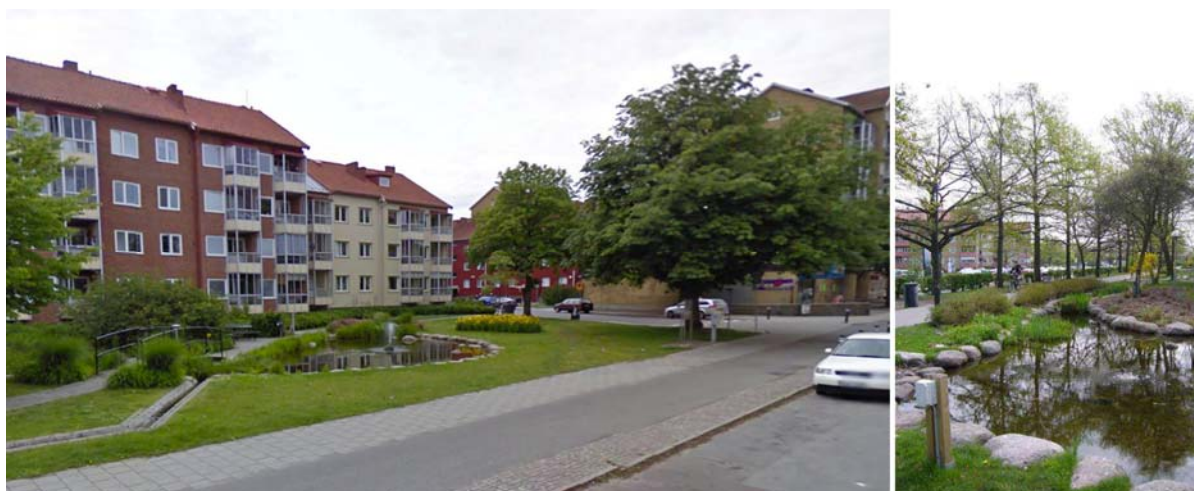
Figura 1. Vista del quartiere Augustenborg a Malmö ed in primo piano il sistema di canalizzazione e di raccolta delle acque, realizzato per adattare il luogo all'aumento della frequenza delle piogge intense e del rischio allagamento.
